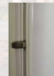
boleć zamka listwowego 3-ryglowego ROTO
